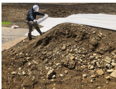
消臭シート敷設 ラップ幅を 50～100 mm
